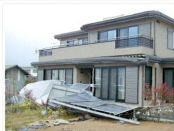
又貸しIDによる無資格工事台風によるパネル落下事故
