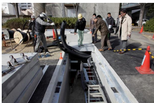
▲配管工事の規模も大掛かりだ
