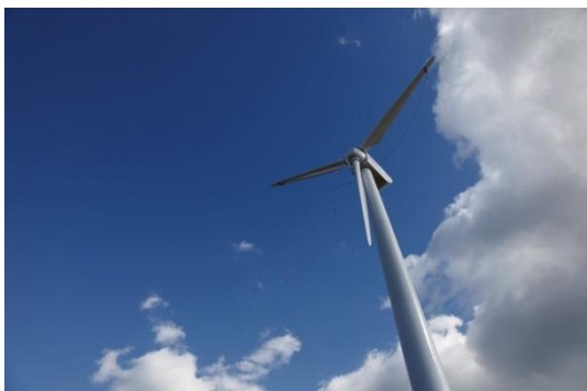
▲風車の高さは約 60m で出力 300kW
