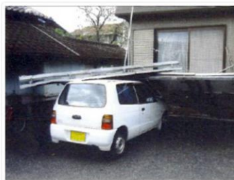
又貸しIDによる無資格工事台風によるパネル落下事故
