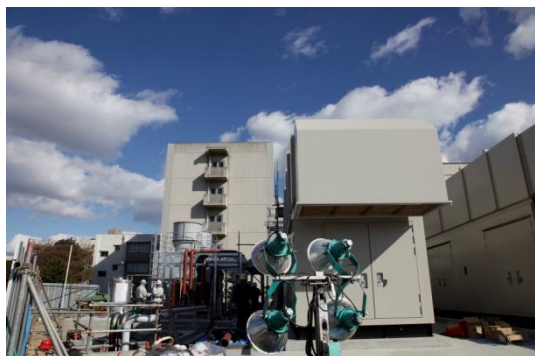
▲コージェネレーション工事
