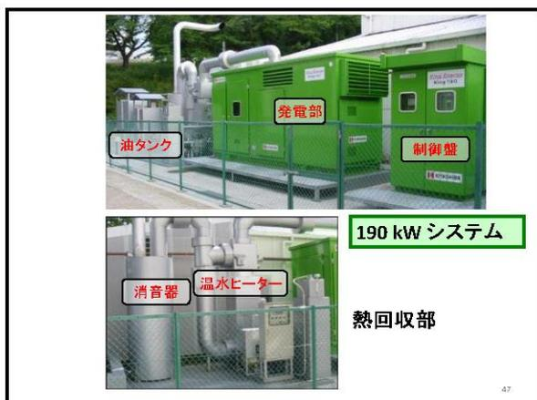
ディーゼルエンジン発電機があって発電し、排熱を回収して工場のお湯を供給している190キロワットのシステムです。
